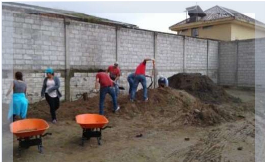
Distribución de la tierra para la construcción del huerto
